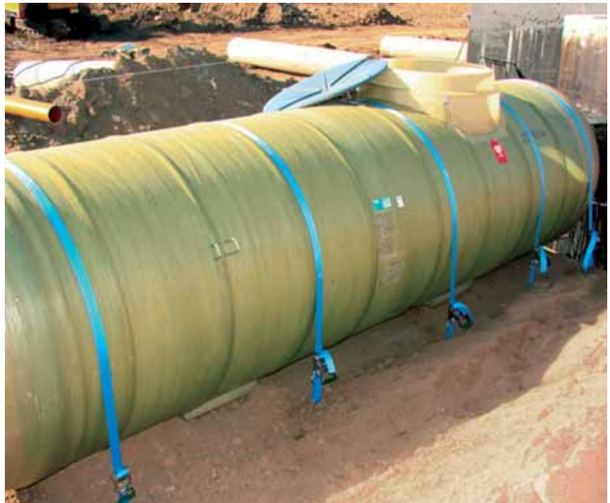
Errotin ankkuroidaan venymättömien polyesteriliinon avulla. Tarvittavien liinon lukumäärä on vähintään sama kuin erottimen pituus metreissä.
