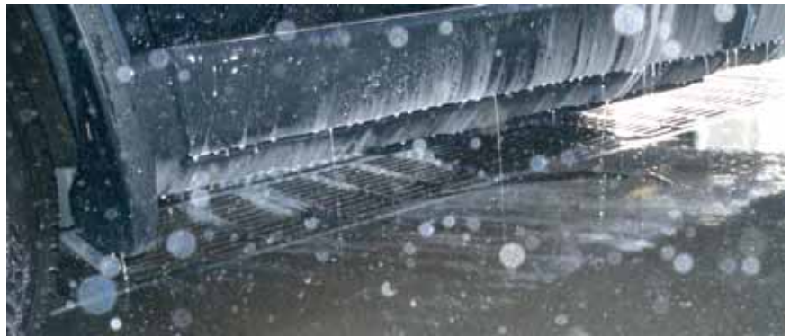
Pesuhallissa ajourille asennettu VEK-vesienkeruukanaali johtaa veden ja kiintoaineen erotinjärjestelmään.
