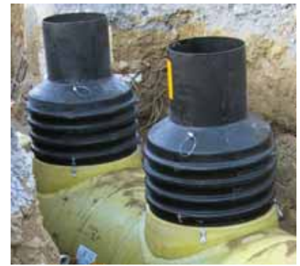
EuroHUK 600 -huoltokaivot asennettuina.
