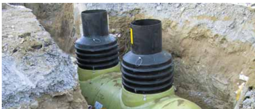
Смонтированный технический колодец EuroHUK.
