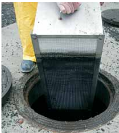
На время обслуживания, коалесцентный модуль поднимается из отделителя.
