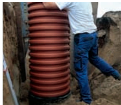
5 Nousuputki asennetaan kaivoon.
