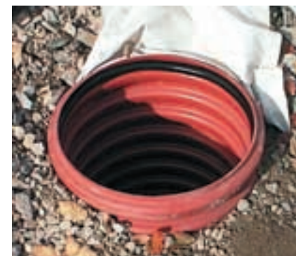
7 Sekä teleskoopin että kelluvan kansiston asennus aloitetaan asentamalla tiiviste nousuputkeen. Sekä tiiviste että teleskooppi voidellaan liukuaineella.
