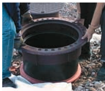
9 Kehys asennetaan teleskooppiin ja kierretään lukittaen paikalleen. Kehys sallii jopa neljän asteen maanpinnan kallistuman.
