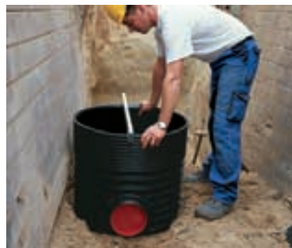
1 Kaivon pohjaosa sijoitetaan kivettömälle putkialustalle. Kaivossa ei ole sisäistä kaltevuutta.
