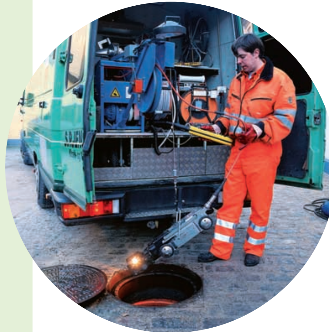
TV-tarkastus ja muut toimenpiteet viemärijärjestelmässä tehdään helposti maan pinnalta käsin.
