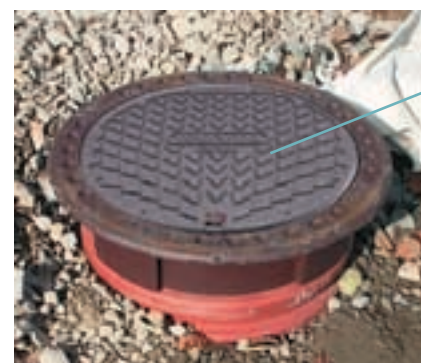
10 Kansi asennetaan paikalleen ja kaivon ympäryksy täytetään ohjeiden mukaisesti, asennuskohteen olosuhteet huomioon ottaen.
