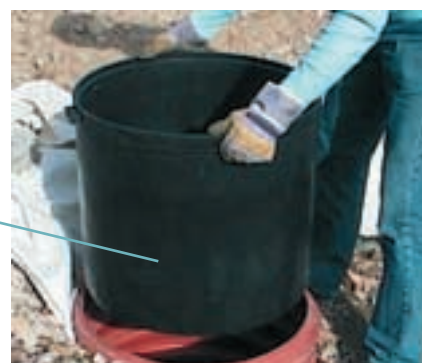
8 Teleskooppi asennetaan nousuputkeen. Teleskoopin avulla saavutetaan 350 mm:n säätövara.
