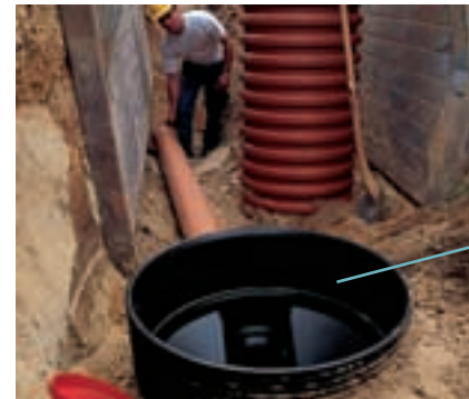
2 Esimerkki pallomuhvin joustavuuden hyödyntämisestä 7,5° kulmassa keskiiviivaan nähden sekä vaaka- että pystysuunnassa.
