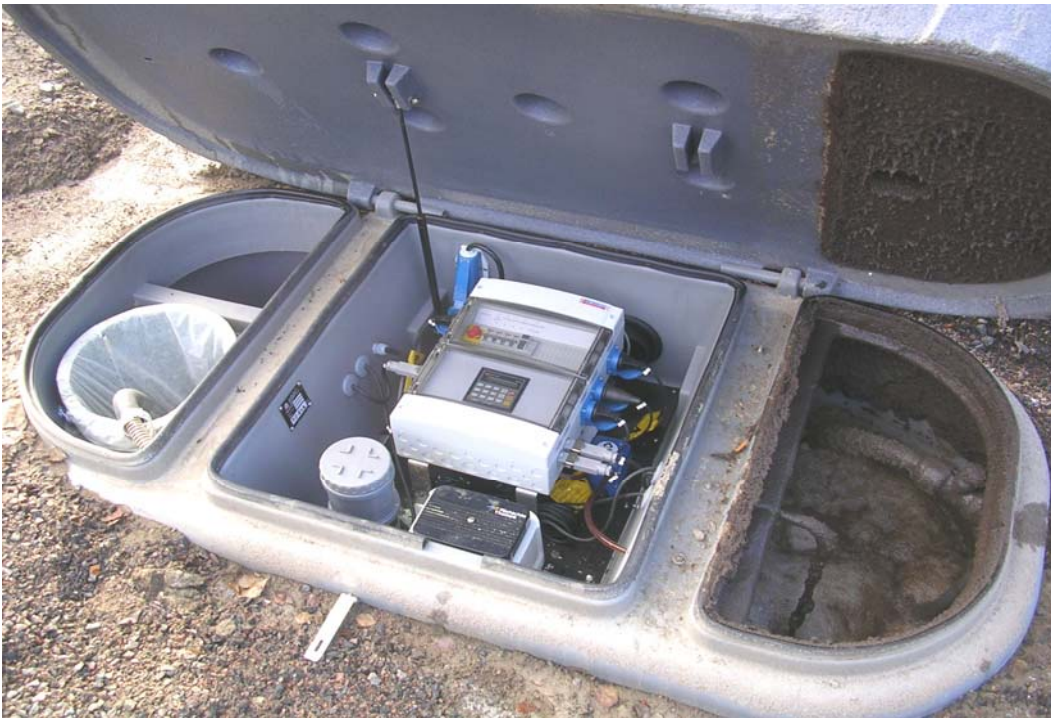
Kuva 3. Kiinteistö 7 (Wehoputs 5 panospuhdistamo). Vasemmalla lietepussi ylijäämälietteelle, keskellä ohjausyksikkö ja oikealla näkyy prosessiallas.
