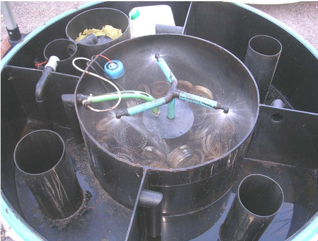
Kuva 2. Kiinteistö 5 (Green Pack Sako Plus 2). Keskellä on puhdistamon biosuodinosa.
